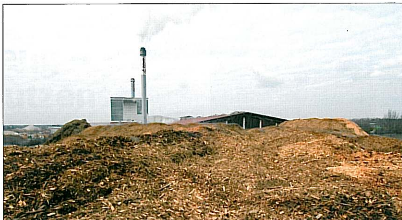
Im Biomasse-Heizkraftwerk der Bioenergie Taufkirchen werden jährlich rd. 100 000 t Hackschnitzel verfeuert, um rd. 250 Kunden mit Wärme zu beliefern
