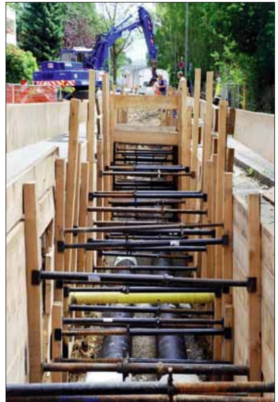
Bild 1. Im Jahr 2008 wurden in Unterföhring die ersten Fernwärmelösungen verlegt
