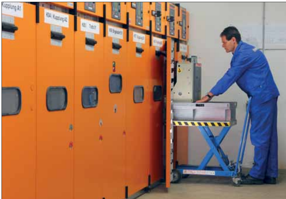
Wartungsarbeiten an einer Mittelspannungsschaltanlage der DB Energie
